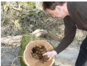
Völlig morsch: Bauhofleiter Dieter Winkler zeigt, dass sich das Holz mancher Äste aufgelöst hat.
