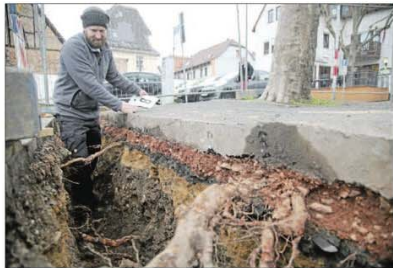
Dominik Scheich sichtet und nummeriert die Wurzeln einer Platane auf dem Parkplatz an der Ecke Pfarrgasse/Ellsabethenstraße. Foto: Reuß
